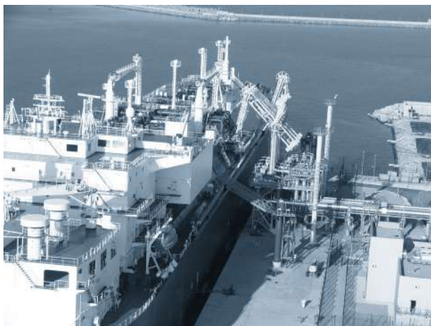
Sagaas , planta de regasificació a Port de Sagunt.
