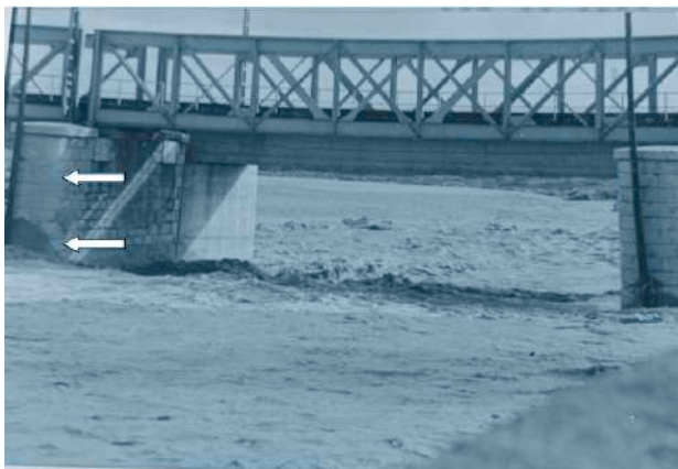
Vista del pont del ferrocarril en la riuada de 1987. He posat dues marques on es representa aproximadament la diferència de nivells entre aquesta crescuda i la de l'any 1957. La fletxa baixa és la de l'any de la foto, encara que a la nit el nivell va ser un poc superior, com es veu per les deixalles de la dreta. Foto de J.M. Palomar.
