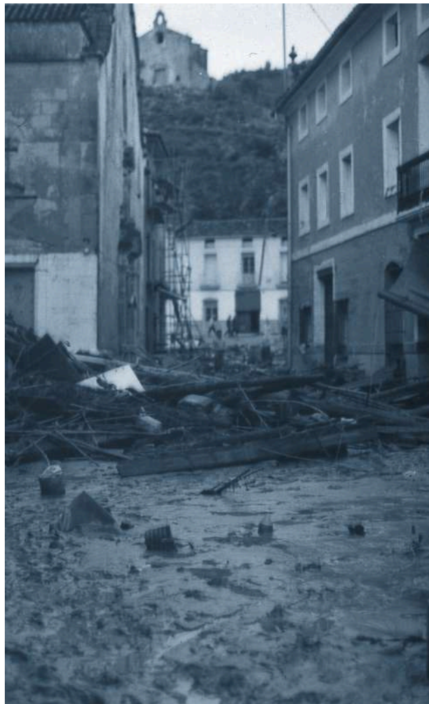
Carrer de Sumacàrcer anegat
