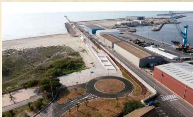
PANTALÀ DEMOLT (2023) I NOU PASSEIG (2024).
