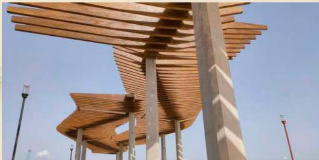
COBERTA DE LÀMINES DE FUSTA PER AL UMBRACLE I NOU PASSEIG DES DE L'AIRE (2024). Fotos: COMSA.
